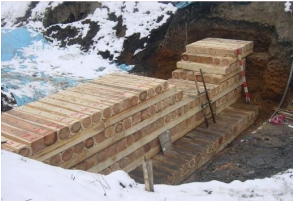
木製治山ダム(オールウッドダム)
