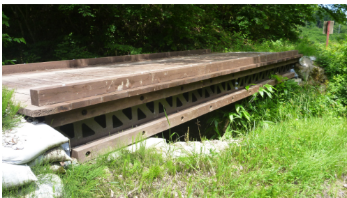
図-1 プレストレス木箱桁橋
