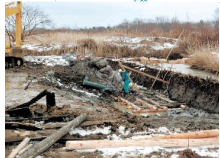
護岸工事の様子
