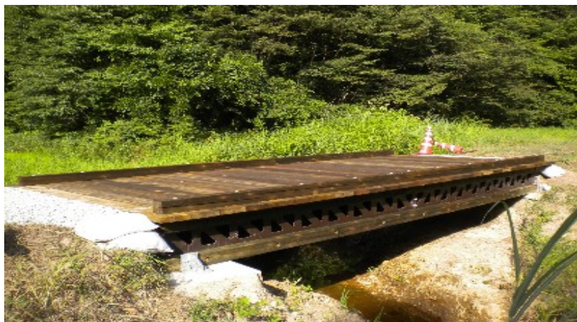
プレストレス木箱桁橋(オンサイト木橋)
